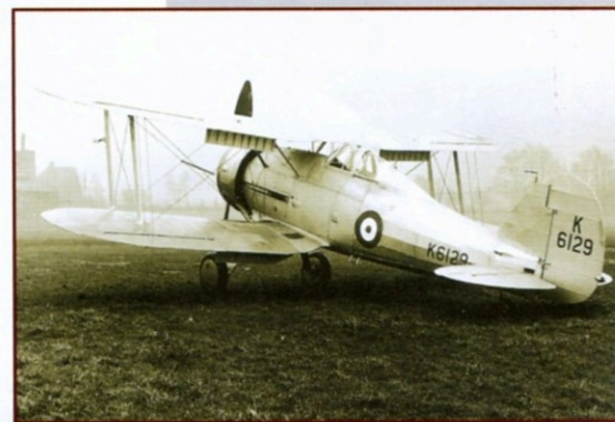
PRVNÍ SÉRIOVÝ GLOSTER GLADIATOR Mk. I (č. K6129) UKAZUJE ZŘETELNÉ ROZDÍLY MEZI TÍMTO LETADLEM A PŘEDCHOZÍM TYPEM GLOSTER GAUNTLET. GLADIATOR MĚL KRYTÝ KOKPIT A HORNÍ I SPODNÍ KŘÍDLA VYBAVENÁ Klapkami.
