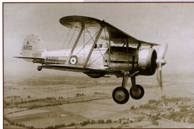
LETÍCÍ PROTOTYP STÍHAČKY GLOSTER SS.37 (č. K5200). PŮVODNĚ ŠLO O RADIKÁLNĚJŠÍ ÚPRAVU LETOUNU GLOSTER GAUNTLET S OTEVŘENOU KABINOU, KRYT KABINY DOSTALY TEPRVE SÉRIOVÉ EXEMPLÁŘE.
