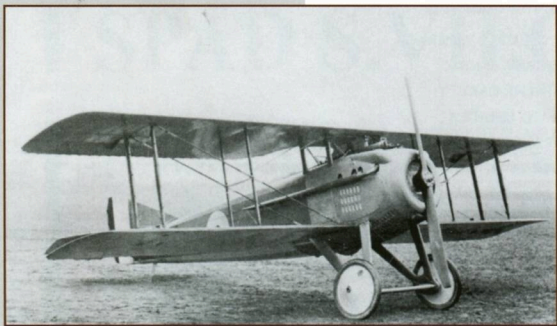
JEDNA Z PRVNÍCH STÍHAČEK SPAD S. VII VYROBENÝCH VE VELKÉ BRITÁNII. NA SNÍMKU JSOU VIDĚT NEVELKÉ OTVORY V KRYTU CHLADIČE, KTERÉ MUSELY BÝT POZDĚJI ZVĚTŠENY, ABY SE ZABRÁNILO PŘEHŘÍVÁNÍ MOTORU. SPADY BRITSKÉ VÝROBY BYLY V MNOHA OHLEDECH HORŠÍ NEŽ FRANCOUZSKÉ STROJE, TAKŽE SE POUŽÍVALY HLAVNĚ K VÝCVIKU PILOTŮ.
