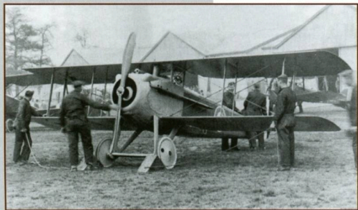
PŘÍPRAVA K NAHOZENÍ MOTORU SPADU S.VII BRITSKÉ VÝROBY.
